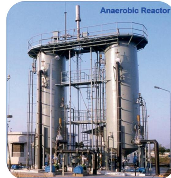
**ANAEROBER REAKTOR FÜR DIE FAULUNG VON KALKSULFID-FETT- UND FLEISCHRESTEN UND SCHLAMM (ERFOLGLOS WEGEN DES HOHEN SULFIDGEHALTS)**
